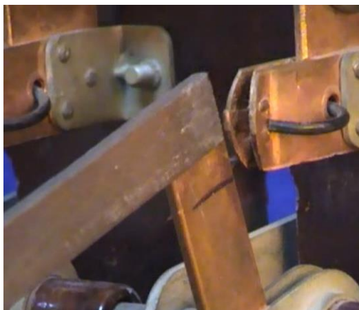
Тщательно очистить напильником контактные поверхности ножей и контактных губок
